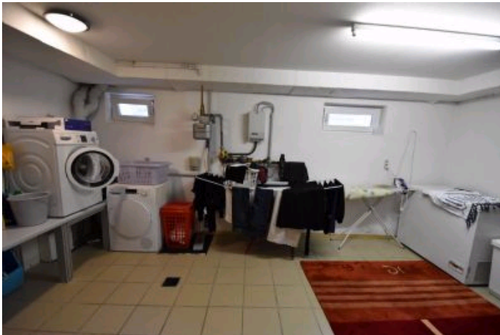
Waschküche im Keller
